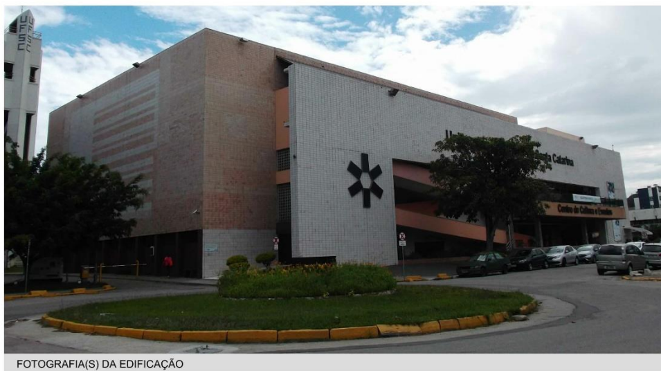
FOTOGRAFIA(S) DA EDIFICAÇÃO
